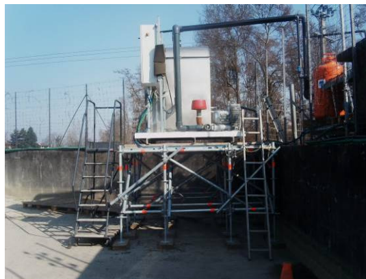
Figure n°5 : Vue d'ensemble de l'unité de stripping.
